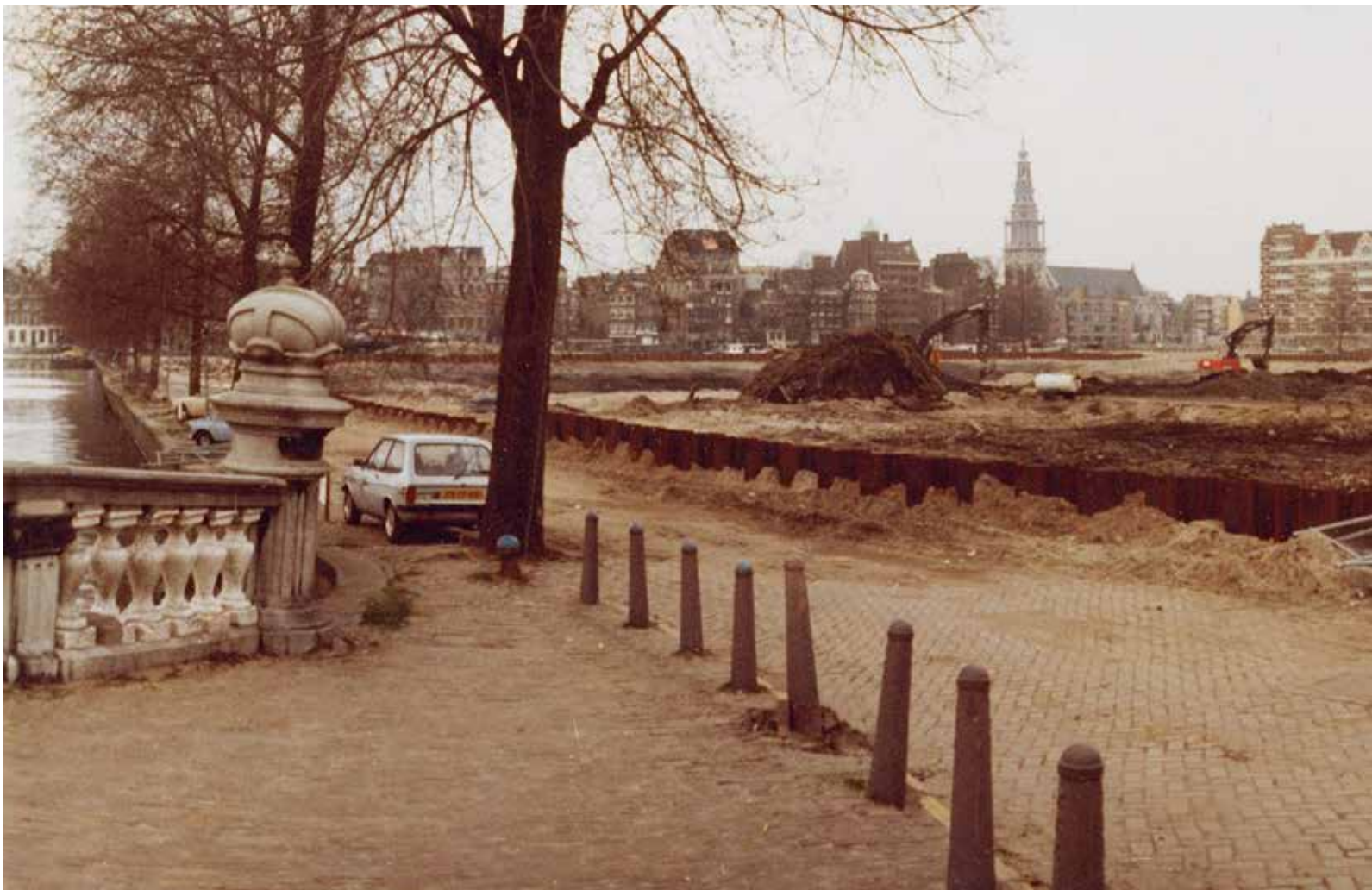
Leegte op het Waterlooplein in voorbereiding op de bouw van stadhuis en muziektheater, maart 1982. Foto uit het Archief van de Dienst Ruimtelijke Ordening. Stadsarchief Amsterdam
